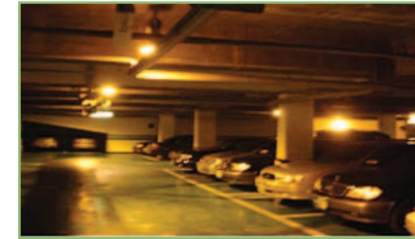
〈그림 5-16〉 불량한 조명으로 범죄발생가능한 지하주차장
